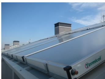
Otra característica incorporada en la casi totalidad de las promociones es la **HE-22** que valora la incorporación de **captadores solares más eficientes**, lo que se debe a la rápida evolución en la calidad de estos elementos para la instalación solar de agua caliente, donde los fabricantes ofrecen colectores cada vez más eficientes y por tanto con valores más bajos para el coeficiente de pérdidas.
